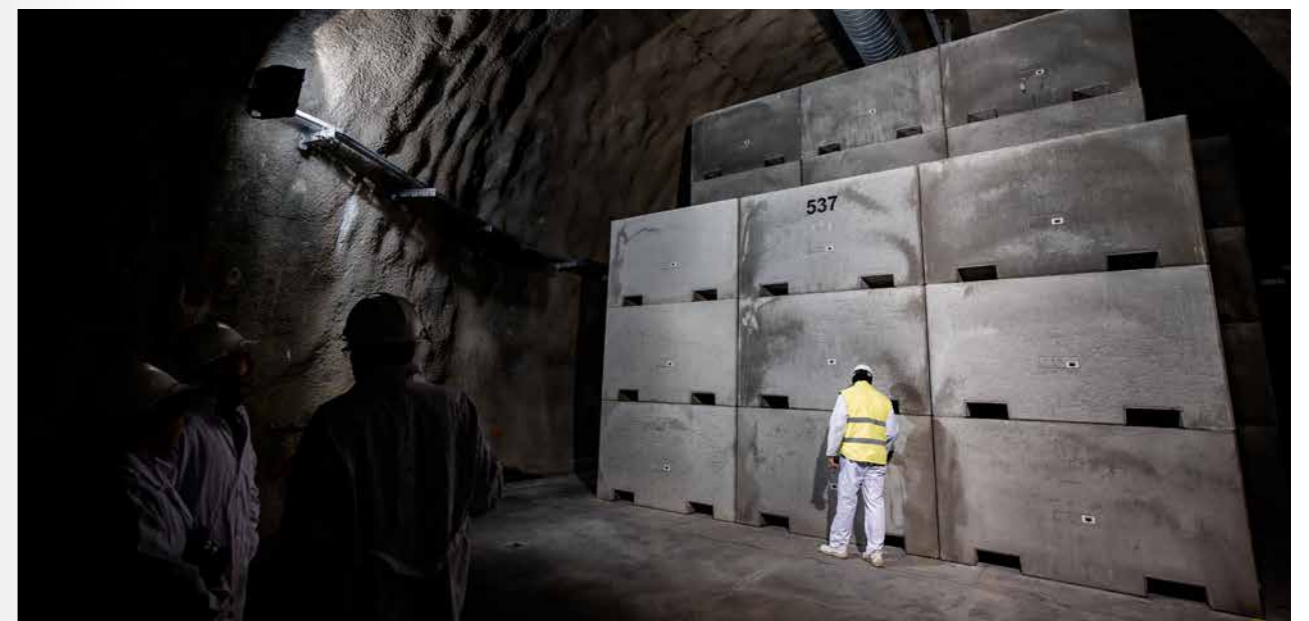
Az eredetileg használt vasbeton konténeresekben – amelyekkel az első kamra telt meg – 9 hordót lehetett elhelyezni, amelyek közé inaktív beton töltötték. Az így kapott csomagok 7 köbméteresek voltak, amelyből 2 köbméter volt radioaktív hulladék. Ezzel szemben a KHCS-k mindössze 2 köbméteresek és szintén 1,8 köbméter radioaktív hulladékot tartalmaznak.
