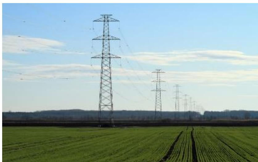
Slika 43. Martonvásár-Győr 400 kV vazdušni vod sa stubovima tipa „FENYŐ“
