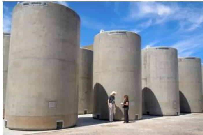
Slika 96. Suvo kontejnersko skladištenje u vertikalnom položaju [42]
