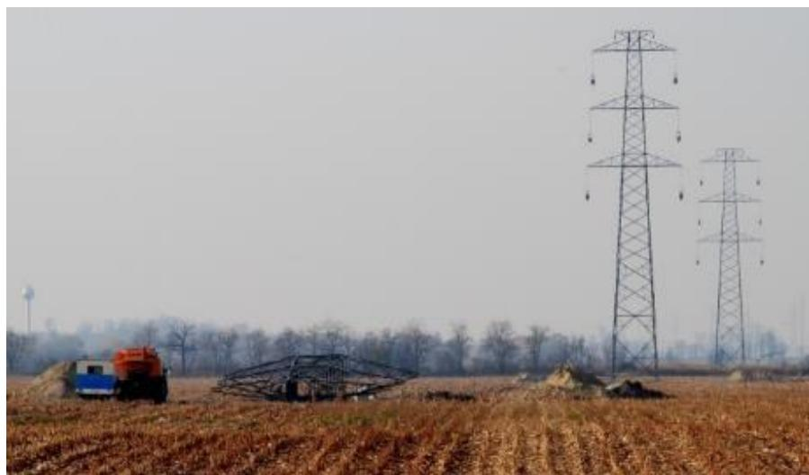
Slika 45. 400 kV vazdušni vod Martonvásár-Győr, montaža stuba
