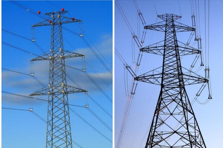
Abbildung 5-3. Halte- und Spannmasse der 400 kV Freileitungen, Isolierketten
