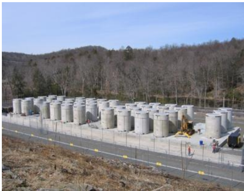
Рисунок 98: Характерний порядок розміщення в разі сухого контейнерного складування.
