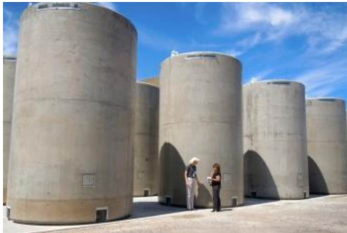
Рисунок 96: Вертикальне, сухе, контейнерне складування [42]
