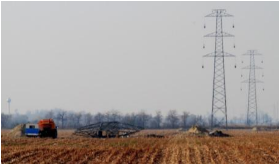
Рисунок 45: Монтаж опори повітряної ЛЕП 400кВ Мартонвашар-Дьйор.
