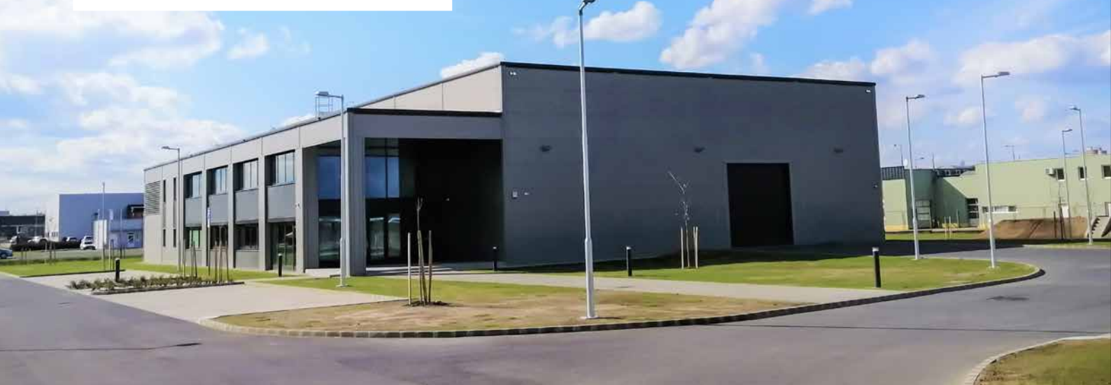
Az új ipari csarnok épülete
